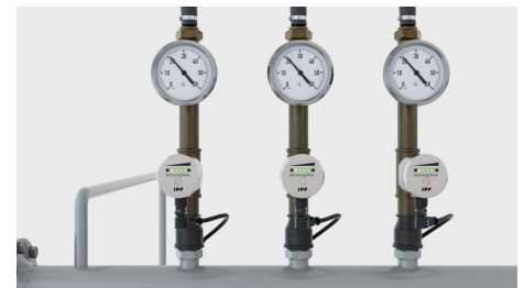
Die Altgeräte wurden an einer Anlage durch die Durchflusswächter von ipf electronic ersetzt. (Bild: ipf electronic)
