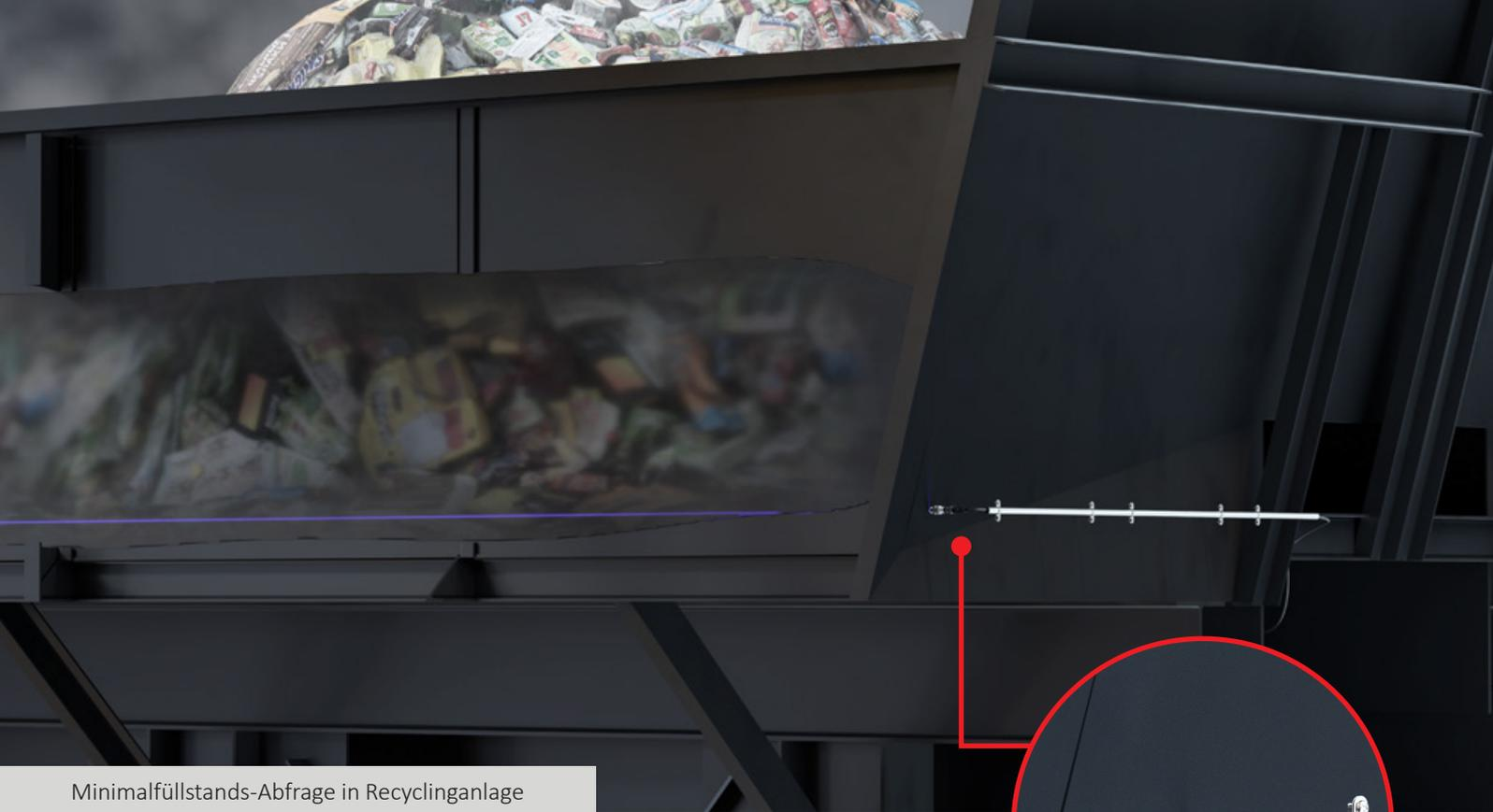
Minimalfüllstands-Abfrage in Recyclinganlage
