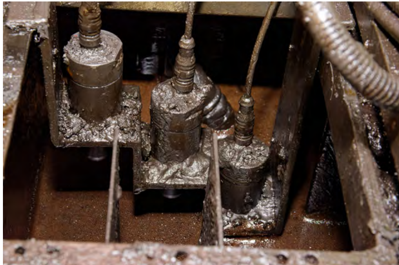
Abb. 6: Sensoren der Baureihe FK92 in einem Vorratsbehälter zur Permanent schmierung von Stanzwerkzeugen.
