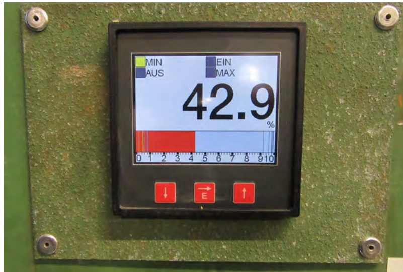
Abb. 35: Der digitale Messumformer BA960900 verarbeitet die für die maximalen und minimalen Füllstände voreingestellten Stromsignale des Füllstandsensors.
