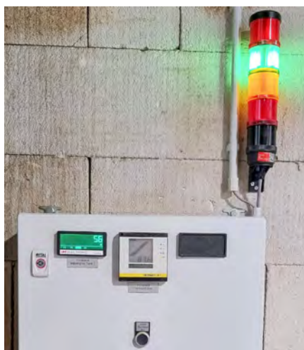
Abb. 30: Das Display des BA050100 gibt die Schaltvorgänge der Meldeleuchten parallel durch entsprechende Farbwechsel wieder.
