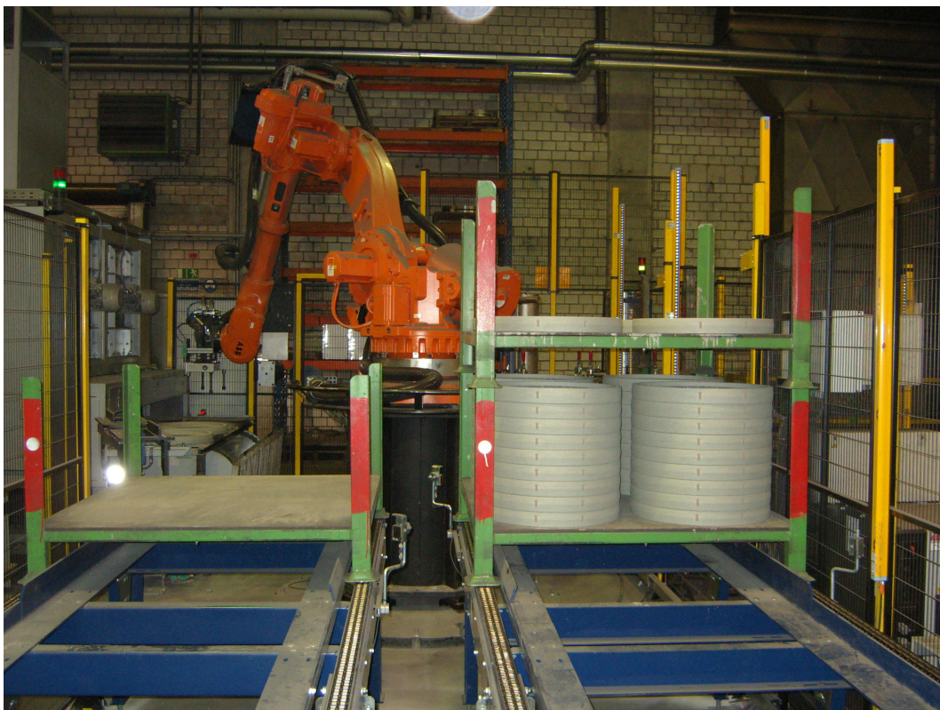
Carga automática de una cinta de horno Imagen: ipf electronic
