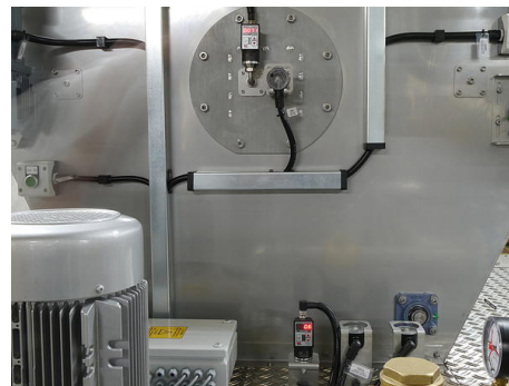
Le DW35311A (photo, en bas). Les signaux analogiques de cet appareil peuvent être utilisés, parallèlement à la mesure continue de la pression dynamique et donc à la détermination du niveau de remplissage dans un bassin, pour s'adresser à l'API de l'installation de filtrage afin de réguler en permanence un entraînement de pompe (à gauche sur la photo) via un convertisseur de fréquence.
