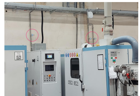
Monitorování stlačeného vzduchu přímo v zařízeních umožňuje přesněji identifikovat problémy a rychleji reagovat, aby bylo možné přijmout vhodná opatření proti plýtvání stlačeným vzduchem.
