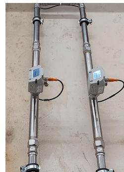
Již integrovaná měřicí část usnadňuje instalaci a zajišťuje laminární, a tedy klidné proudění média, které je nezbytné pro vysoce přesná měření. (všechny obrázky: ipf electronic gmbh)
