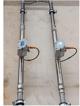
Die bereits integrierte Messstrecke erleichtert die Montage und sorgt für eine laminare und damit beruhigte Strömung des Mediums, die für hochgenaue Messungen erforderlich ist. (alle Bilder: ipf electronic gmbh)
