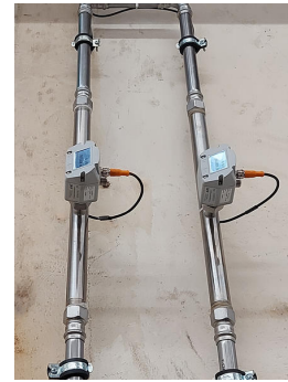
La sección de medición integrada facilita la instalación y garantiza un flujo laminar y, por tanto, tranquilo del medio, necesario para realizar mediciones de gran precisión. (todas las imágenes: ipf electronic gmbh)
