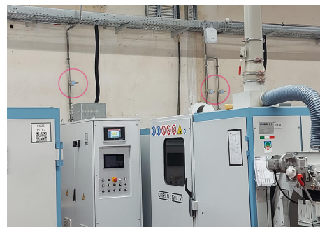
Monitorowanie sprężonego powietrza bezpośrednio w systemach umożliwia dokładniejszą identyfikację problemów i szybszą reakcję w celu podjęcia odpowiednich środków zapobiegających marnotrawstwu sprężonego powietrza.
