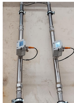
Zintegrowana sekcja pomiarowa ułatwia instalację i zapewnia laminarny, a zatem spokojny przepływ medium, co jest wymagane do bardzo dokładnych pomiarów. (wszystkie zdjęcia: ipf electronic gmbh)
