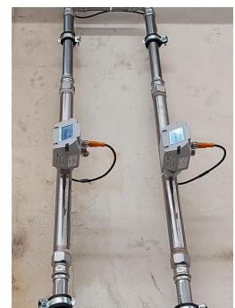
集成的测量部分使安装更加简便，并确保介质的层流和平静流动，这是高精度测量所必需的。(所有图片：IPF 电子有限公司)
