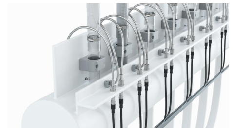
Na skleněných trubcích na zpětné straně KTL, které byly připojeny k jednotlivým vysílačům a přijímačům, bylo nutné nainstalovat celkem 312 optických světlovodů s kovovým pláštěm.
