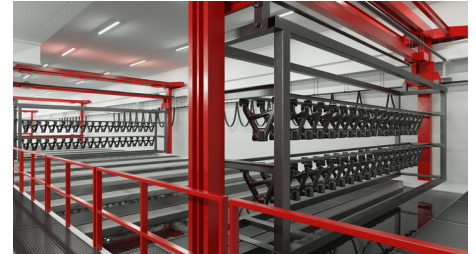
Todo o processo de revestimento catódico por imersão requer um total de 12 etapas de processo individuais e consiste em vários tanques de grande volume dispostos uns atrás dos outros. (Todas as imagens: ipf electronic gmbh)
