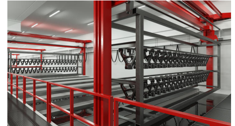
整个阴极电泳涂装工艺总共需要 12 个独立的工艺步骤，由多个大容量储罐依次排列组成。(所有图片：IPF electronic gmbh)
