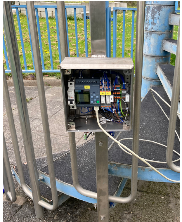
Die Signalauswertung und -weiterverarbeitung der beiden Sensoren übernimmt eine mit der RGB-LED-Signalleuchte verbundene Siemens Logo, wobei Julian Hooge hier auch die komplette Verdrahtung übernahm. (Foto: Martinrea Bergneustadt GmbH)
