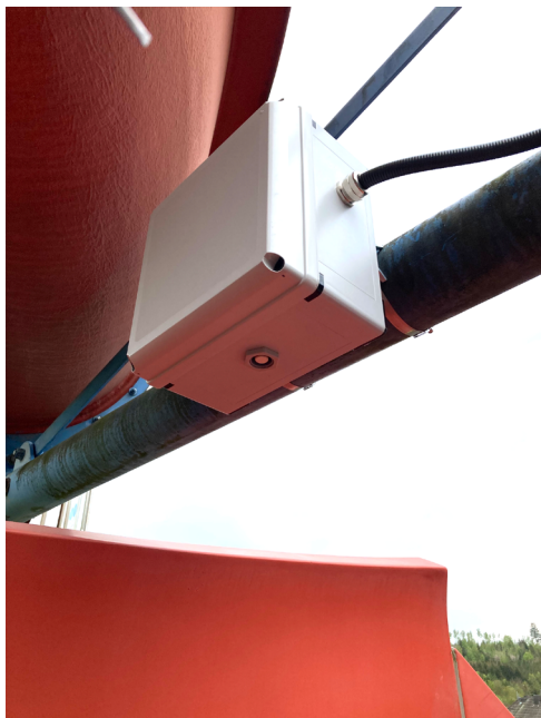
Der Ultraschallsensor wurde oberhalb der Rutsche montiert und war danach nur schwer erreichbar. Da aber das Analogsignal (4...20mA) direkt in der Steuerung ausgewertet werden konnte, ließ sich der Arbeitsbereich des Sensors sehr komfortabel einstellen, ohne hierzu ständig die Rutsche betreten zu müssen. (Foto: Martinrea Bergneustadt GmbH)
