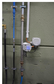
Třetí laserový řezací stroj musel být vybaven SL950020 bylo třeba stanovit pouze spotřebu stlačeného vzduchu, protože empirické hodnoty byly již k dispozici u dvou jiných systémů, zejména pokud jde o technické plyny.
