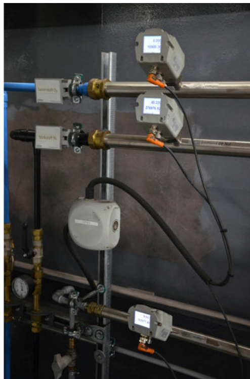
Pomiary zużycia energii w systemie cięcia laserowego w Kettenwulf SY92E297 (powyżej) do pomiaru tlenu, SY92E296 (w środku) (azot jako medium referencyjne) i SL910020 (na dole) do sprężonego powietrza.
