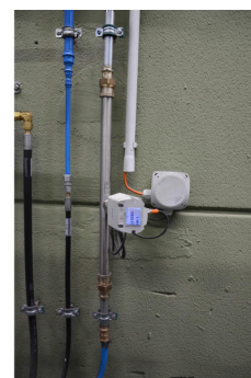
A terceira máquina de corte a laser tinha de ser equipada com uma SL950020 só foi necessário determinar o consumo de ar comprimido, uma vez que já existiam valores empíricos de dois outros sistemas, nomeadamente no que diz respeito aos gases técnicos.
