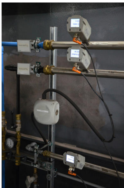
对 Kettenwulf 的激光切割系统进行消耗量测量：SY92E297 SY92E297(上图)用于测量氧气，SY92E296(中间)（参考介质氮气）和 SL910020(底部)用于测量压缩空气。
