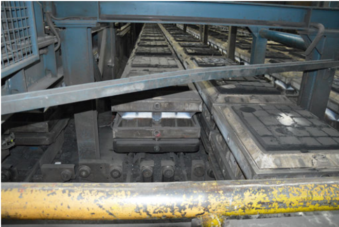
Der Kühlstrecke verläuft über insgesamt sechs Bahnen, auf denen die Gussbehälter im Rundlauf transportiert und positioniert werden.
