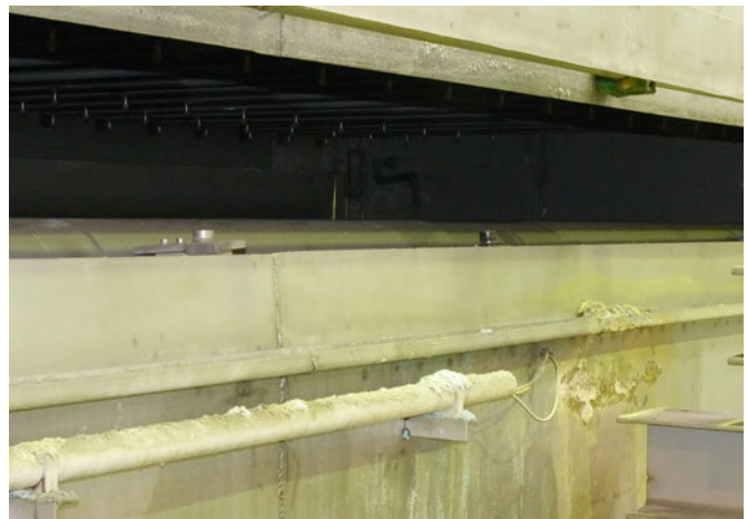
Jeweils drei parallel betriebene induktive Sensoren sind am Ein- und Ausgang der Beizkammer positioniert. Die spezielle Anordnung gewährleistet, dass ein größerer Bereich der Kupferplatte von der Unterseite abgefragt werden kann und somit mindestens ein Sensor anspricht.
