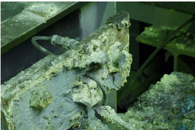
Die säurehaltige Beize setzt den Laserlichtschranken in den Pufferzonen extrem zu, wie deutlich zu erkennen ist, dennoch arbeiten die Sensoren, die knapp oberhalb der Rollengänge installiert wurden, zuverlässig.
