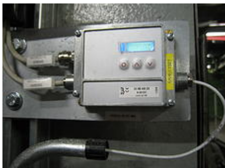
ipf_FHW_Neukoelln006: Samostatná vyhodnocovací jednotka je připojena ke snímači pomocí konečného kabelu a obsahuje osvětlený LCD displej se snadno přístupnými senzory difuzního odrazu pro programování.
