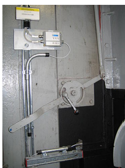
Senzory zaznamenávají vnější teploty stěn zásobníku a přenášejí měřicí signál do samostatné vyhodnocovací jednotky. Ta tyto informace převádí na analogové proudové signály, které jsou odečítány prostřednictvím I/O modulů a v závislosti na teplotní křivce vyvedeny do řídicí jednotky systému ve velinu jako předběžné varování nebo alarm.
