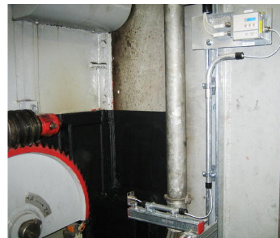
Infračervená měřicí hlava senzorového systému namontovaná na profilu OI98A920 se stupněm krytí IP65 je jedna z nejmenších na světě (prostřední obrázek níže) a měří teplotu stěny u zásobníku krmiva ve vzdálenosti 300 mm ve společnosti FHW Neukölln bezkontaktním způsobem s rozlišením 22:1.
