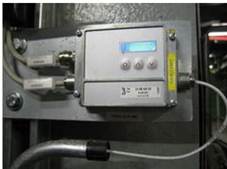
Die separate Auswerteeinheit ist über ein Kabel mit dem Sensor verbunden und integriert ein beleuchtetes LCD-Display mit leicht zugänglichen Tasten zur Programmierung.
