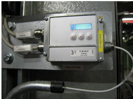
L'unité d'évaluation séparée est reliée au capteur par un câble et intègre un écran LCD éclairé avec des touches facilement accessibles pour la programmation.
