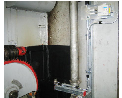
La tête de mesure infrarouge fixée sur un profilé du système de capteurs OI98A920 en indice de protection IP65 compte parmi les plus petites au monde (photo du milieu, en bas) et détecte sans contact la température de la paroi de la trémie d'alimentation à une distance de 300 mm dans le FHW Neukölln avec une résolution de 22:1.
