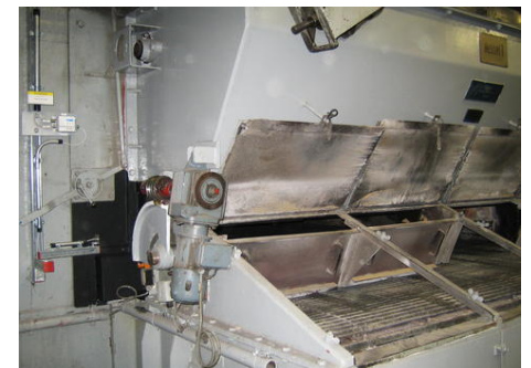
红外线传感器和独立的评估装置安装在行进炉排的一侧（图中左侧）。
