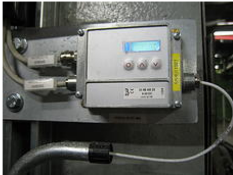
独立的评估装置通过电缆与传感器连接，并集成了一个发光 LCD 显示屏和方便使用的编程按钮。
