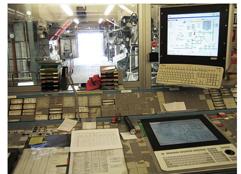
每台锅炉的警告或警报都分别以视觉信息和声音信号的形式传送到监控中心（照片）。
