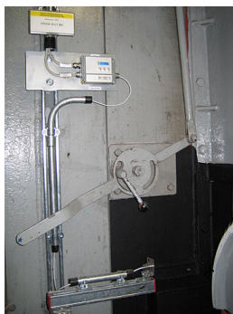
传感器记录料斗壁的外部温度，并将测量信号传输到独立的评估单元。它将这些信息转换成模拟电流信号，通过 I/O 模块读出，并根据温度曲线输出到控制室的系统控制器，作为预先警告或警报。
