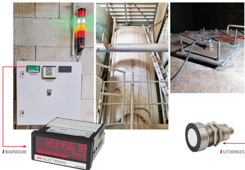
El sensor ultrasónico se montó en la zona de la tapa de un contenedor de silo (derecha). El transductor (izquierda) se encuentra en un armario de control cerca del silo (centro).
