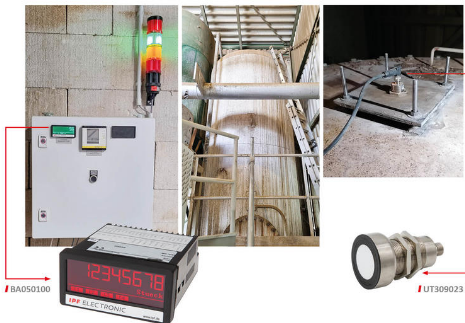
超声波传感器安装在筒仓容器的盖子区域（右）。传感器（左）位于筒仓附近的控制柜中（中）。
