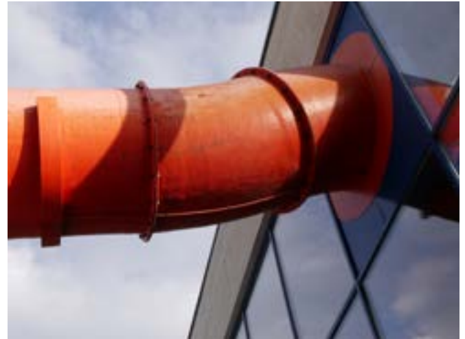
Eine Hochleistungslichtschranke befindet sich unterhalb der Abdeckung (links) unmittelbar hinter dem Eingang der Rutsche.
