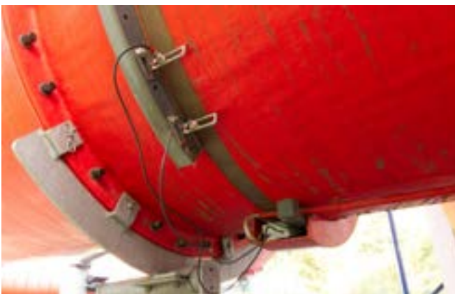
Blick unter die Abdeckung am Ende der Röhre. Hier installierte man zwei Systeme, wobei auf jeder Seite der Rutsche im Wechsel jeweils die Sender (oben) bzw. Empfänger (unten) einer Lichtschranke montiert wurden.
