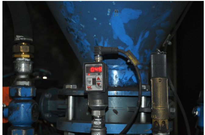
Aus nahezu jeder Perspektive gut ablesbar ist das große, 4-stellige Display zur Anzeige der Messwerte.
