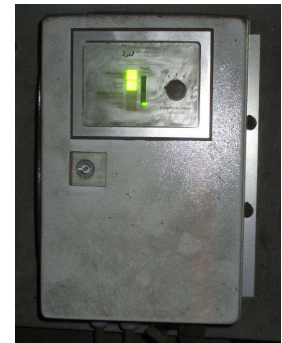
Chování odezvy cívky detektoru lze nastavit prostřednictvím vyhodnocovací jednotky.
