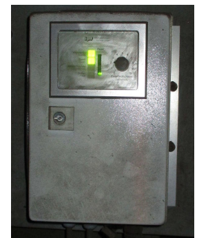
Über die Auswerteeinheit kann das Ansprechverhalten der Detektorspule eingestellt werden.
