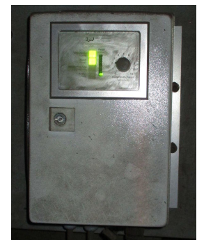
El comportamiento de respuesta de la bobina detectora puede ajustarse a través de la unidad de evaluación.
