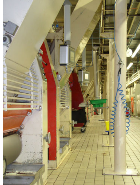
Vor rund fünf Jahren entschloss sich Stollwerck zur schrittweisen Modernisierung der Walzwerke (links).
