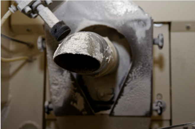
ipf electronic_Farbsensor_Weizen_Roggen-Mühle_001.jpg: Die Papiersäcke werden automatisiert über einen Stutzen abgefüllt, auf dem sich Mehl abgelagert. Diese variierenden Mehlablagerungen stellten bei der Entwicklung der Sensorlösung eine besondere Herausforderung dar.
