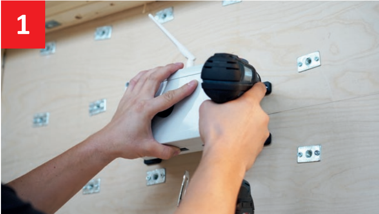
1 Basisstation an Kletterrückwandseite befestigen
